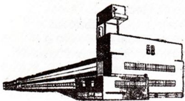
Рис. 2. Архитекторы Гладков и Николаев. Хлопчатобумажная прядильная фабрика "Красная Талка" в Иваново-Вознесенске, 1927 г.
