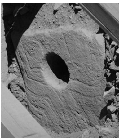
Рис. 13. Отверстия, просверленные в колоннах. Вид сверху
